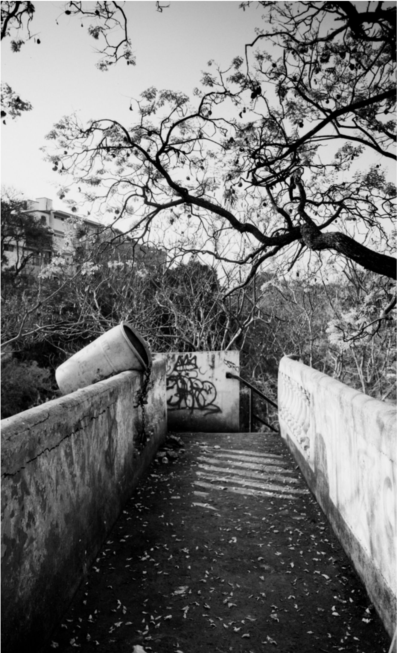
■ Imagen 239. Puente del puente. Puente peatonal del puente del Dragón. Dolores Parral. 2026.
