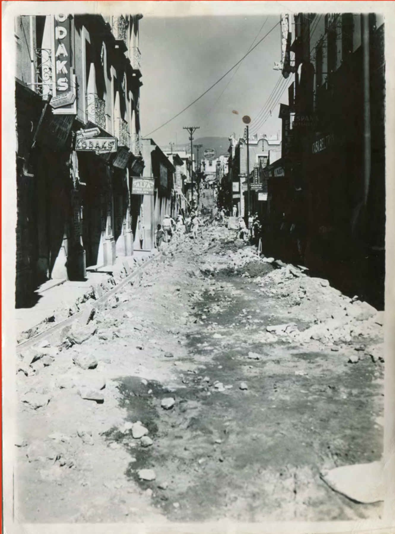
■ Imagen 123. Obra pública en calle Guerrero. Autor: Sin identificar. 1945. Reproducción autorizada por el INAH.
