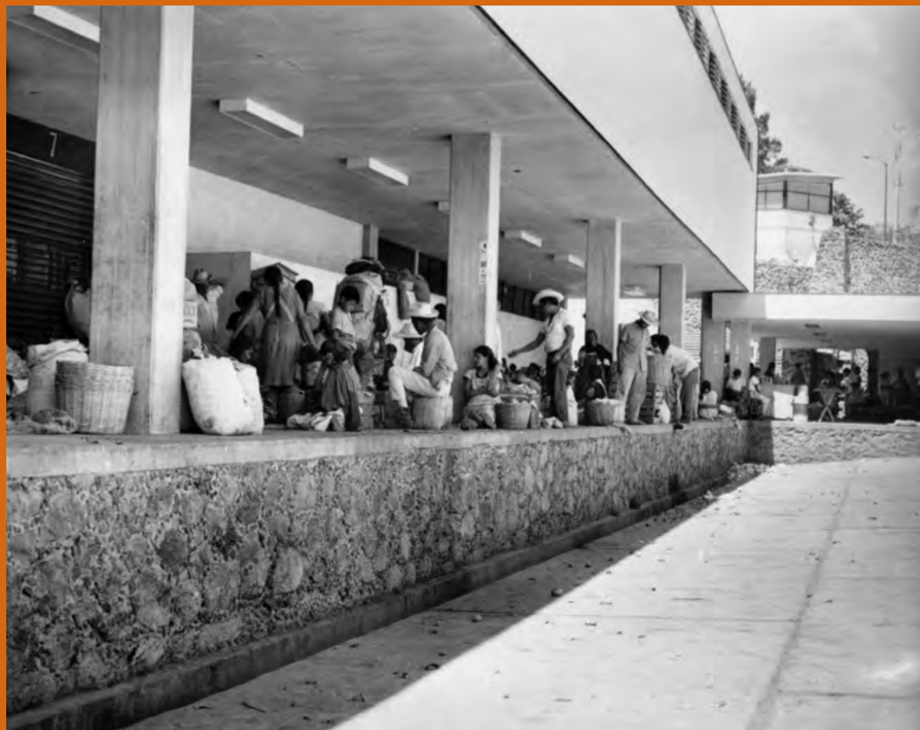
■ Imagen 226. Escena cotidiana durante obras públicas y puente del Dragón (Area de bodegas estacionamiento norte del mercado ALM). Autor: Sin identificar. 1965. Reproducción autorizada por el INAH.
