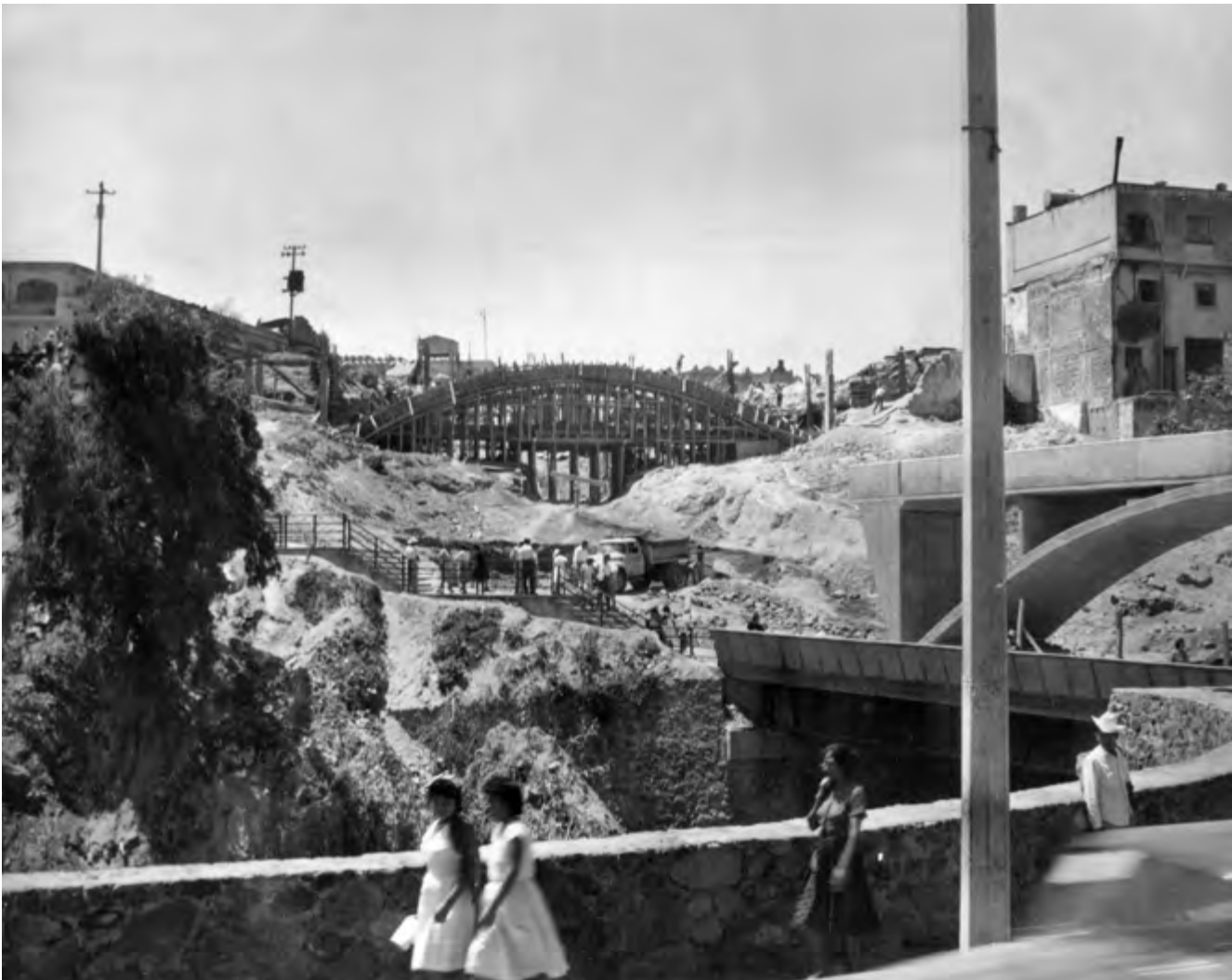
■ Imagen 238. Vista de obra pública durante demolición de mercado "Benito Juárez". (vista de la construcción de los puentes del dragón y clavijero desde Av. Adolfo López Mateos). Ibarra. 1964. Reproducción autorizada por el INAH.
