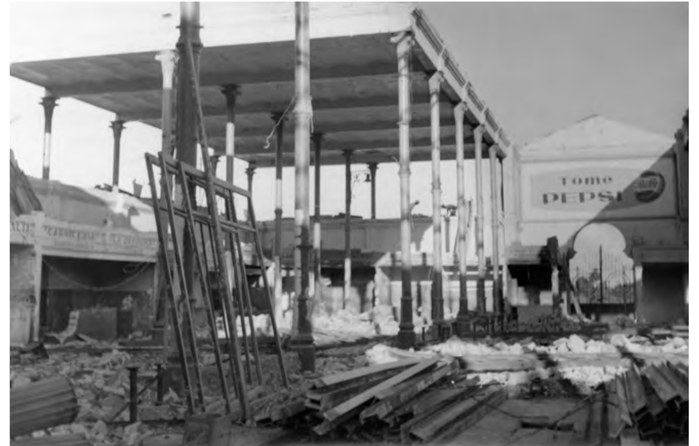
■ Imagen 204. Demolición del mercado "Benito Juárez" 2. Ibarra. 1964. Reproducción autorizada por el INAH.
