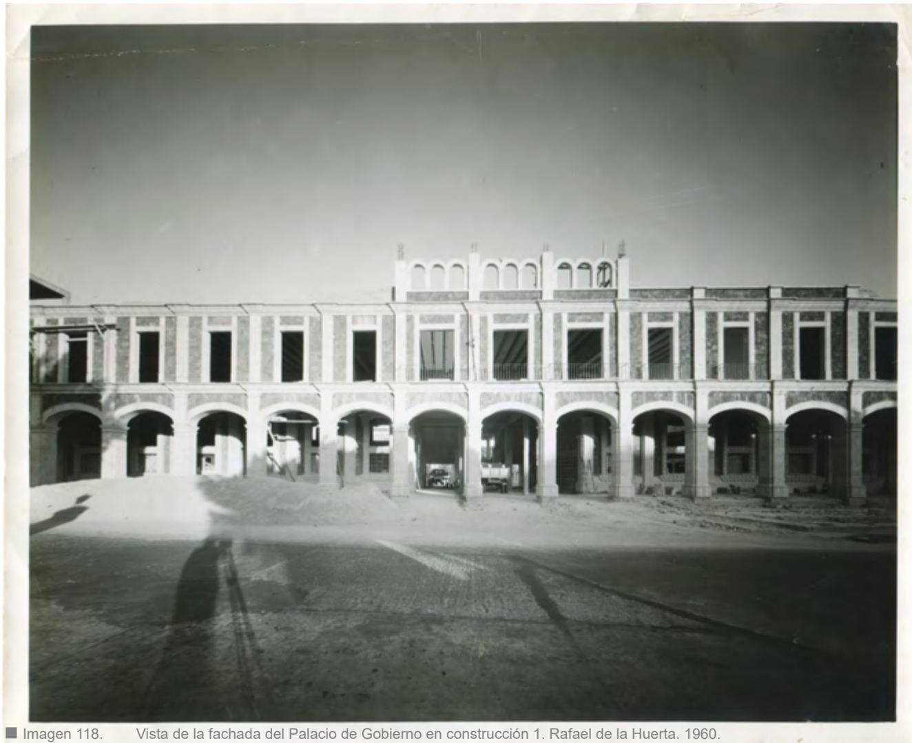
■ Imagen 118. Vista de la fachada del Palacio de Gobierno en construcción 1. Rafael de la Huerta. 1960. Reproducción autorizada por el INAH.
