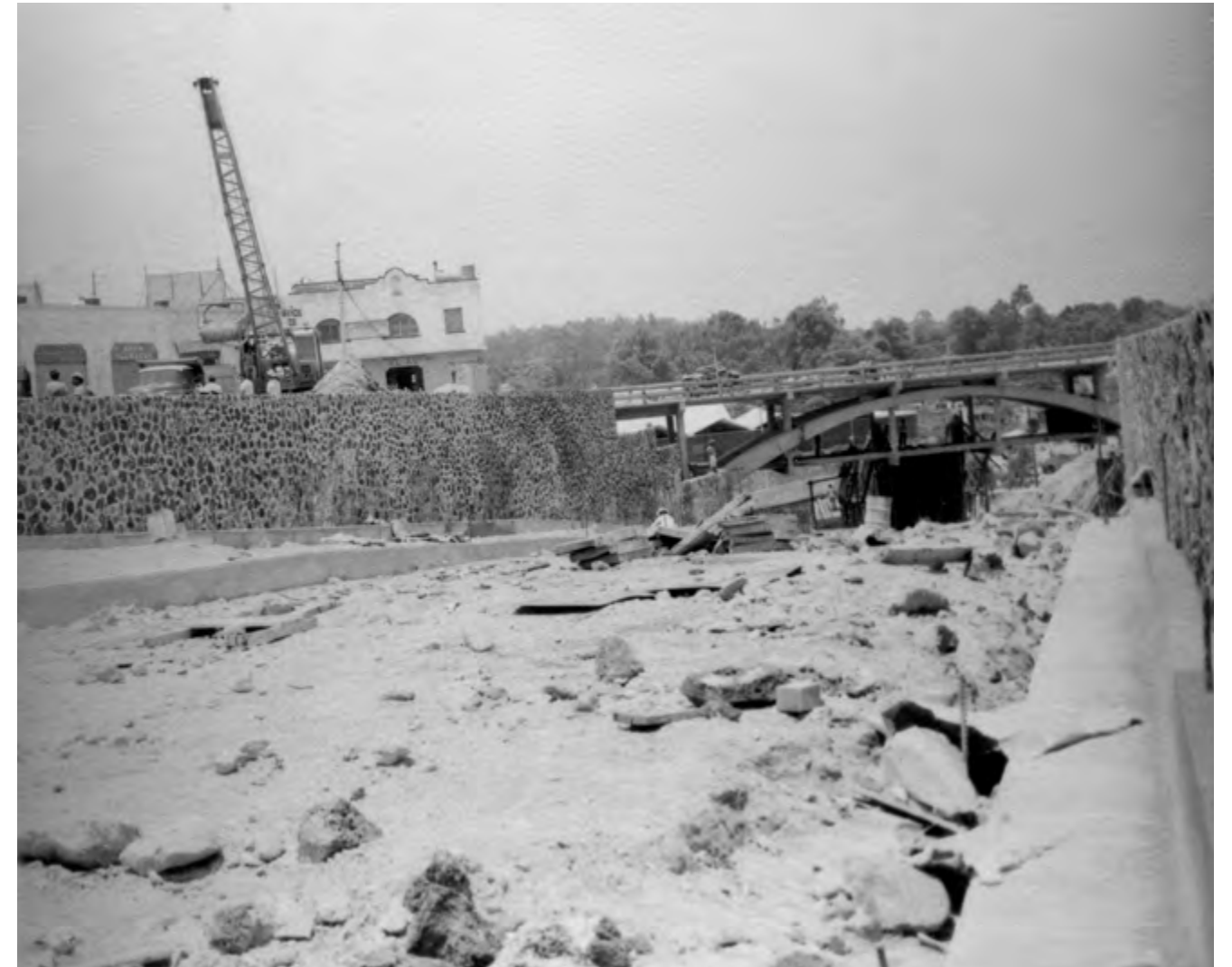
■ Imagen 220. Construcción del puente del Dragón. Autor: Sin identificar. 1965. Reproducción autorizada por el INAH.
