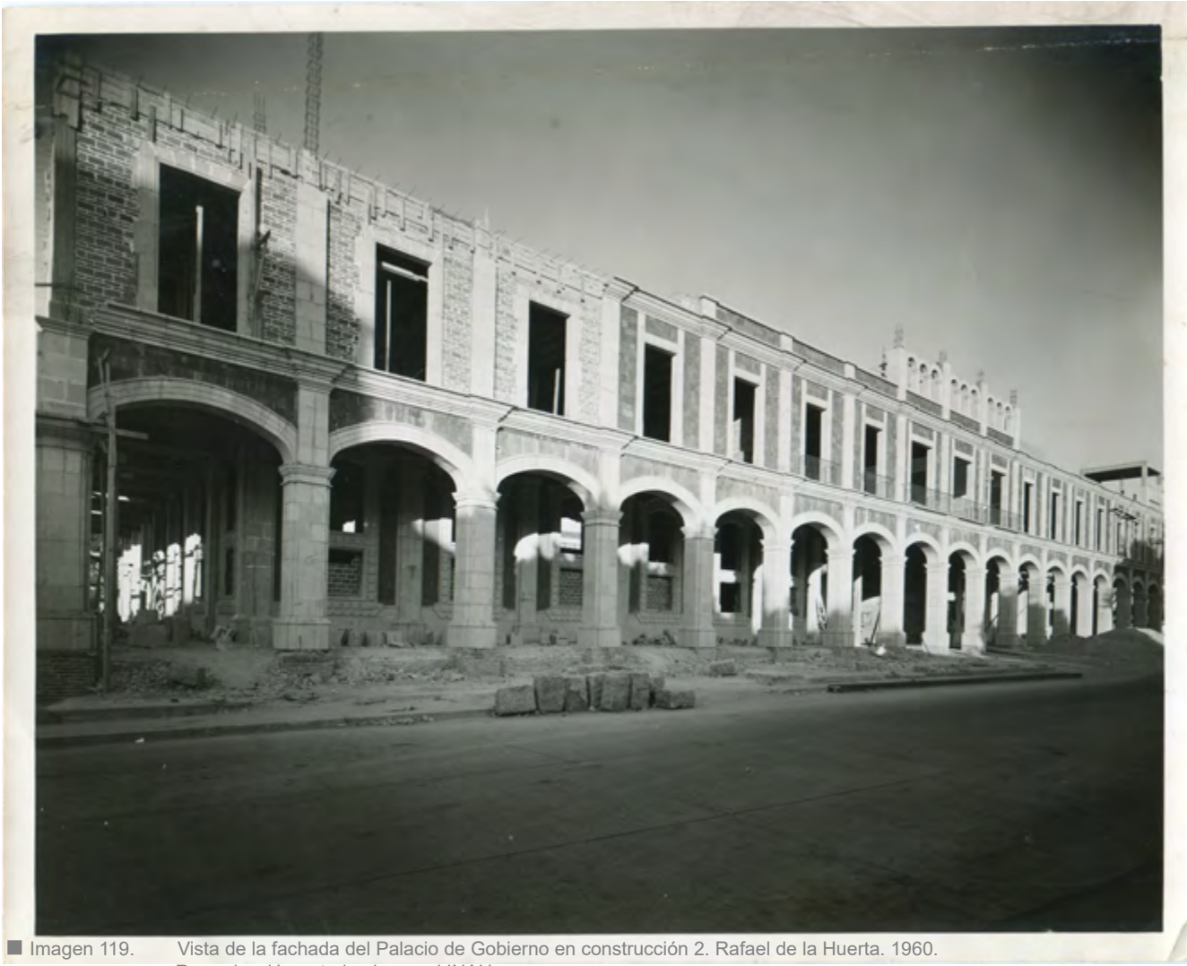
■ Imagen 119. Vista de la fachada del Palacio de Gobierno en construcción 2. Rafael de la Huerta. 1960. Reproducción autorizada por el INAH.
