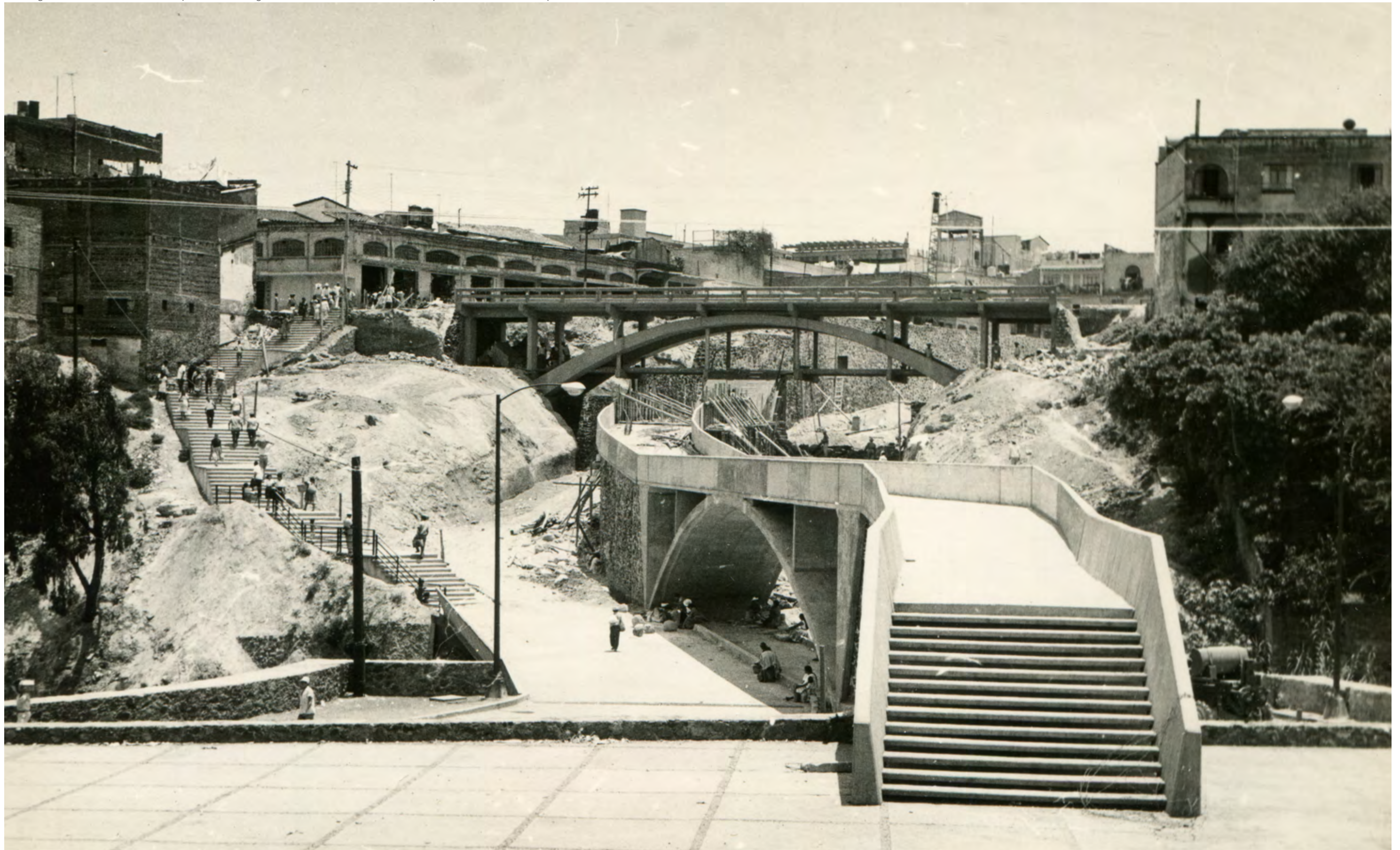
■ Imagen 228. Construcción del puente del Dragón. Autor: Sin identificar. 1965. Reproducción autorizada por el INAH.
