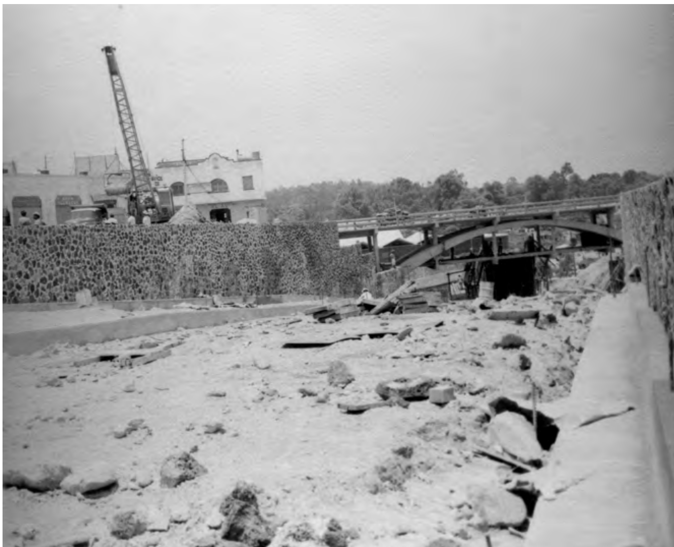
■ Imagen 220. Construcción del puente del Dragón. Autor: Sin identificar. 1965. Reproducción autorizada por el INAH.
