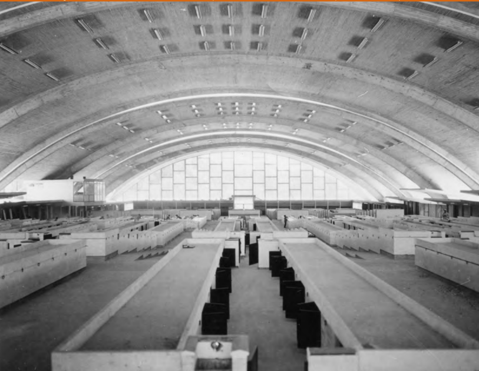
■ Imagen 224. Vista de la nave del mercado “Adolfo López Mateos”. Autor: Sin identificar. 1965. Reproducción autorizada por el INAH.
