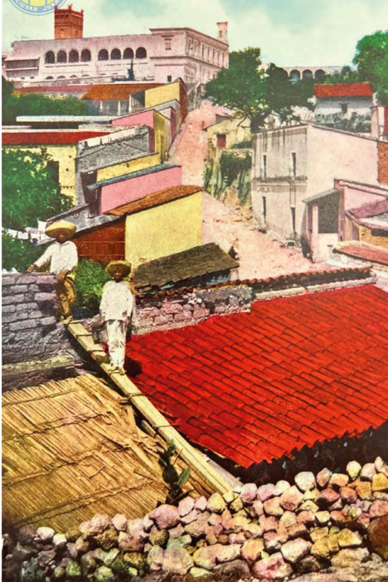
■ Imagen I. "Rear view of Cortes' Palace: Cuernavaca México". Espalda del Palacio de Cortés. Sonora News Company, City of México. Ac. 1904-1908. Especiales, UACJ.
