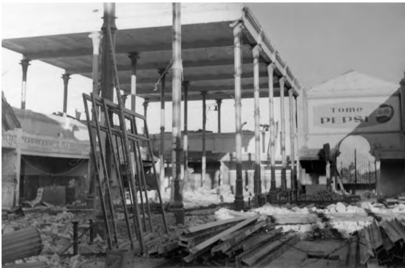
■ Imagen 204. Demolición del mercado "Benito Juárez" 2. Ibarra, 1964. Reproducción autorizada por el INAH.
