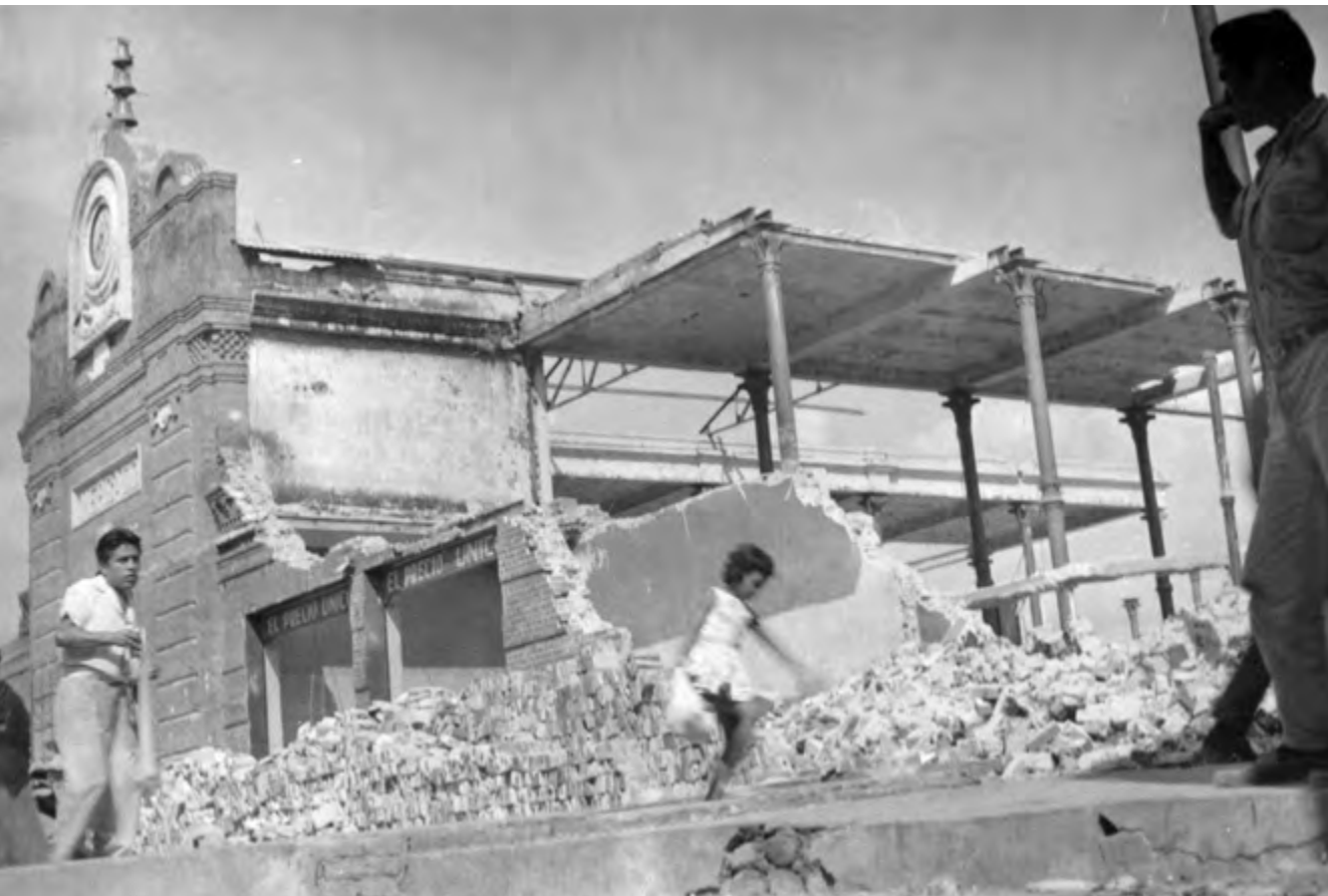
■ Imagen 203. Demolición del mercado “Benito Juárez”, Ibarra. 1964. Reproducción autorizada por el INAH.
