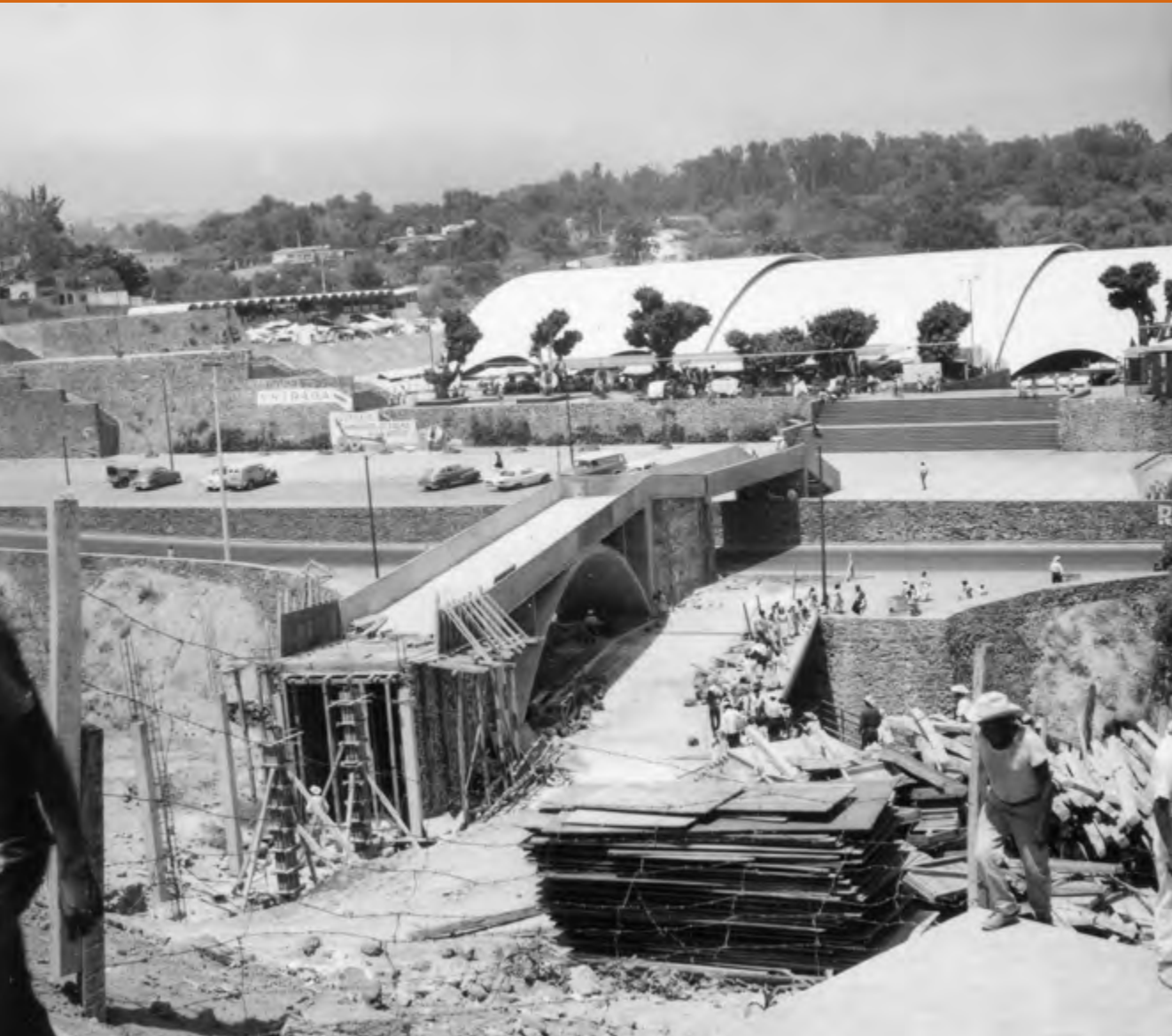
■ Imagen 209. Construcción del puente del Dragón. Autor: Sin identificar. 1965. Reproducción autorizada por el INAH.
