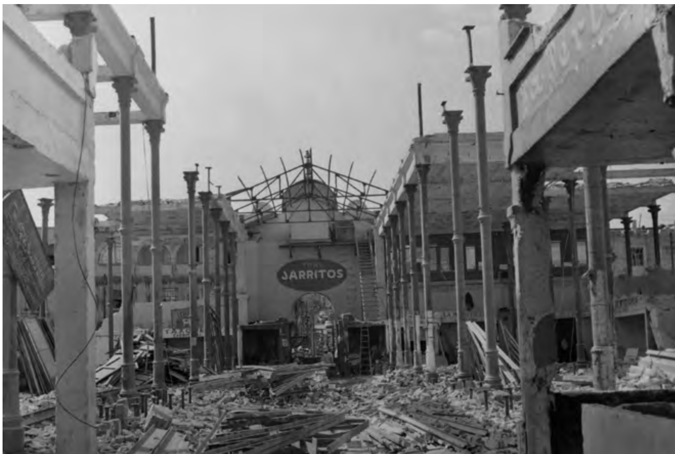
■ Imagen 205. Vista de Oriente a Poniente del mercado Juárez durante su demolición. Ibarra. 1964. Reproducción autorizada por el INAH.
