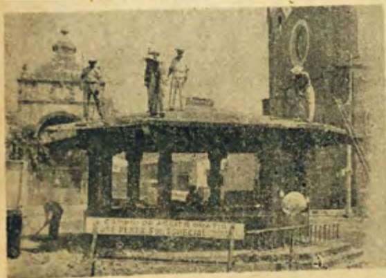
EL ANTIESTETICO mercado de las flores situado frente al chapitel de El Calvario, ha sido derribado para instalar en su lugar una réplica de la Primorosa Fuente de Ocuituco.
