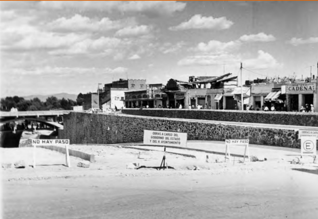
■ Imagen 194. Obra pública municipal, prolongación de la calle Degollado hacia al nuevo mercado “Adolfo López Mateos”. Autor: Sin identificar. 1965. Reproducción autorizada por el INAH.
