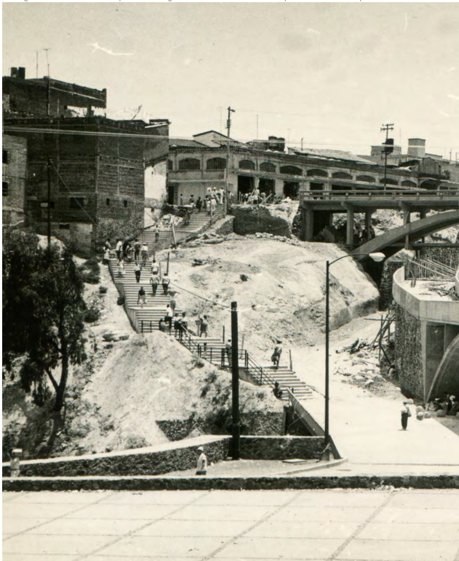
■ Imagen 228. Construcción del puente del Dragón. Autor: Sin identificar. 1965. Reproducción autorizada por el INAH.
