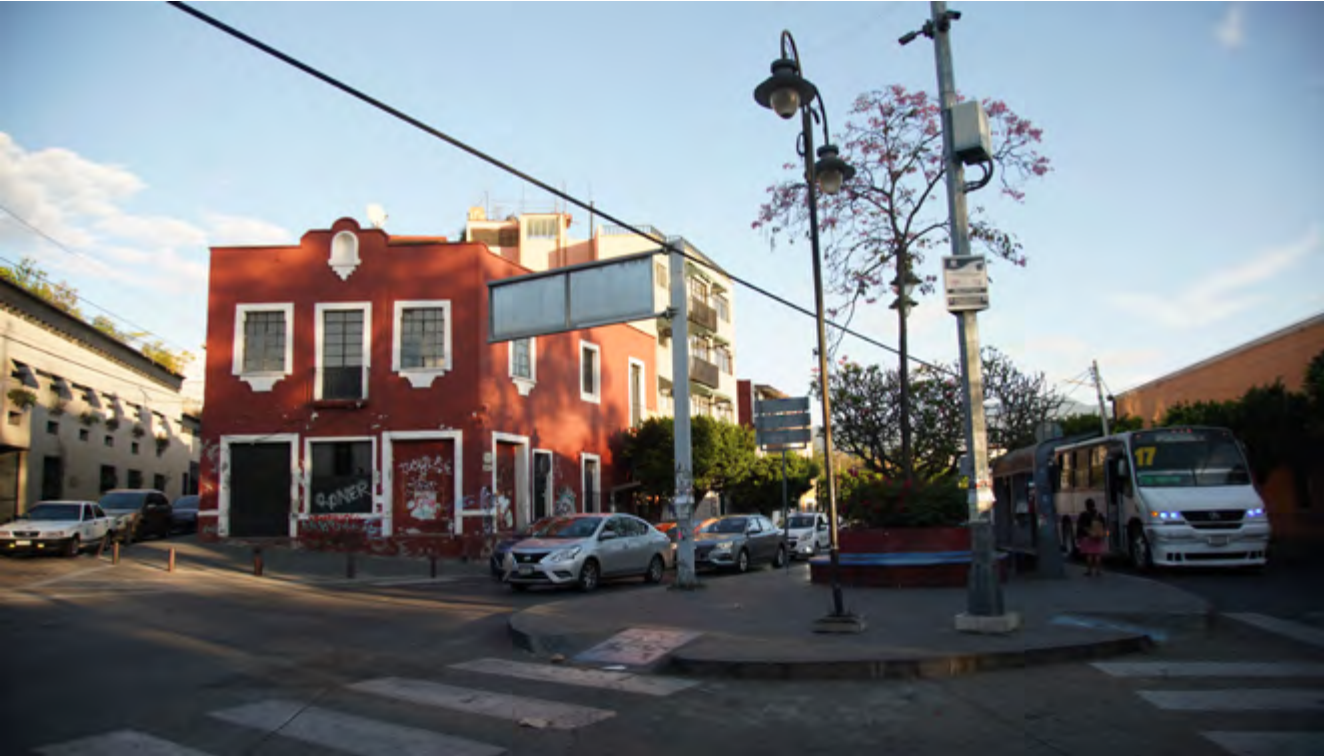
■ Imagen 068. Matamoros y Leandro valle 2, cuchilla de Leandro Valle y Matamoros en dirección del centro hacia el Puente de Porfirio Díaz. Alejandro Linares. 2026.
